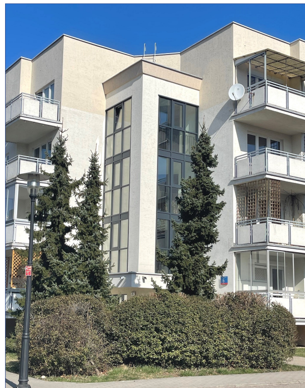
Kamińskiego 6 w trakcie remontu
