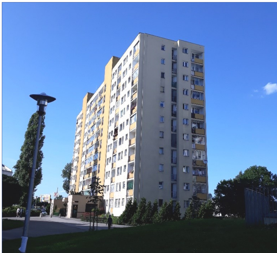
Radzywińska 68/72 przed remontem elewacji
