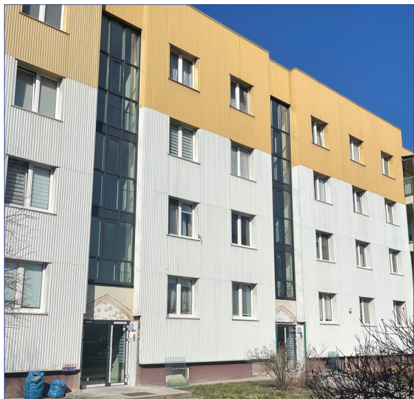
Kamińskiego 16 w trakcie wymiany przeszkleń klatek schodowych
