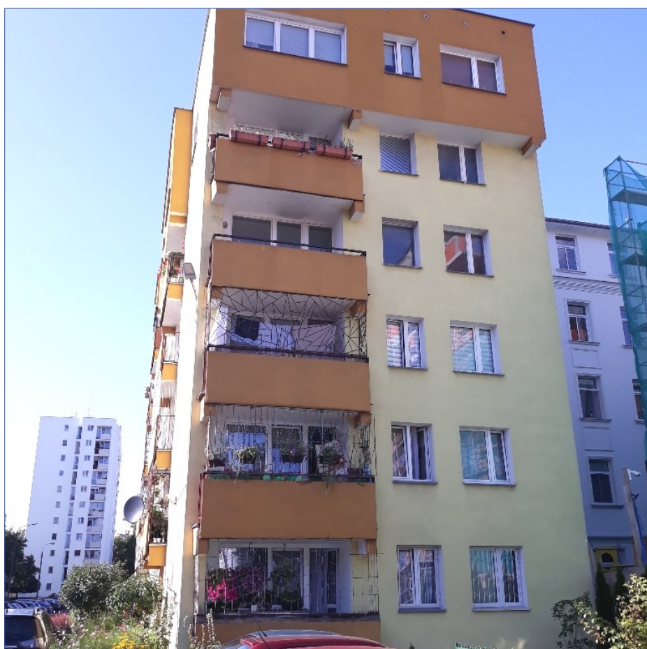
Łochowska 34 przed remontem elewacji
