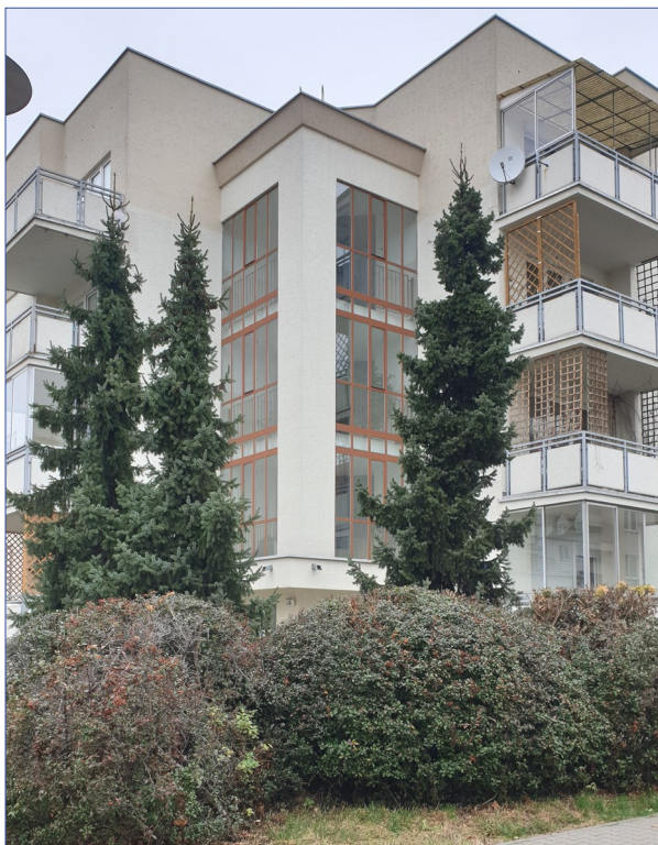
Kamińskiego 6 przed remontem
