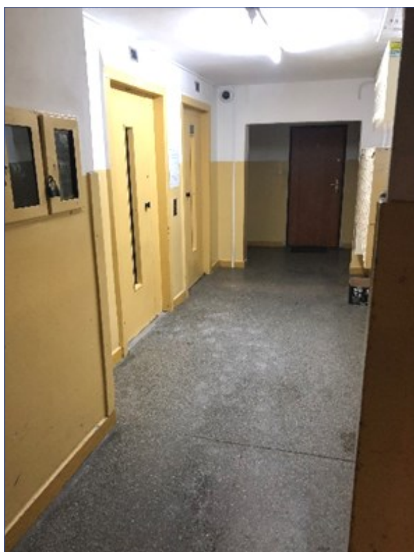
Olgierda 44 klatka schodowa przed remontem
