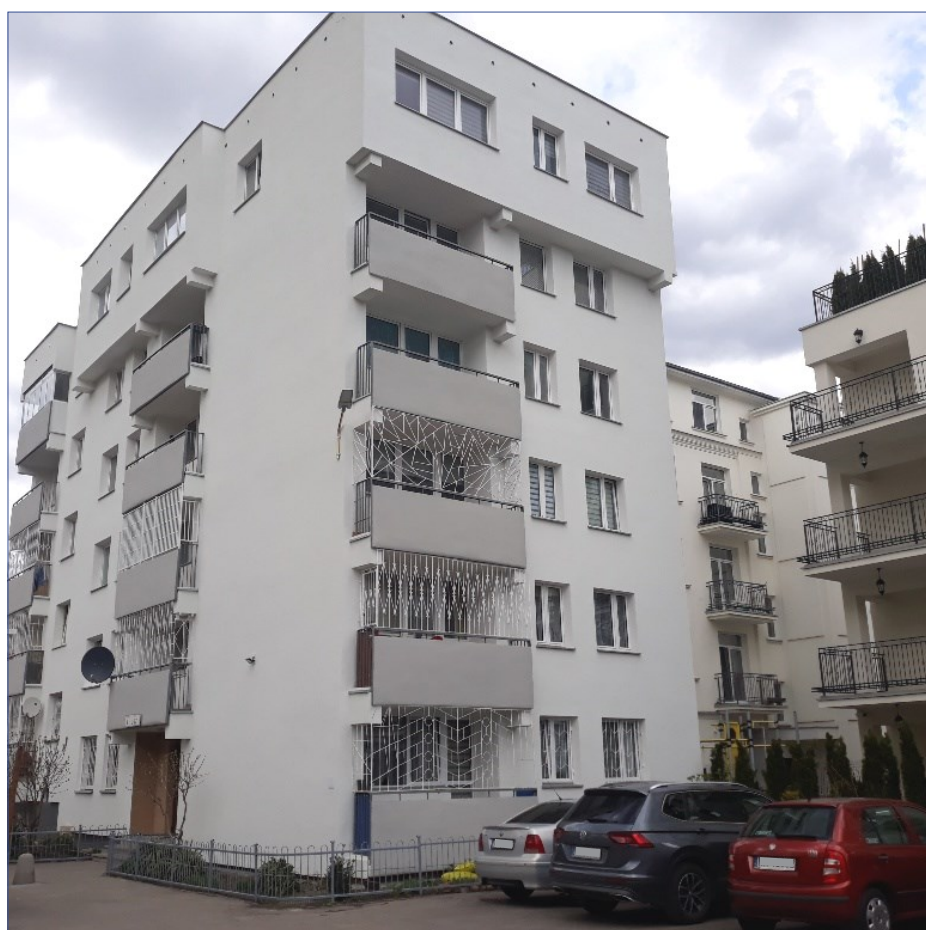
Łochowska 34 po remoncie elewacji
