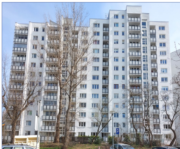
Prałatowska 2 w trakcie renowacji elewacji
