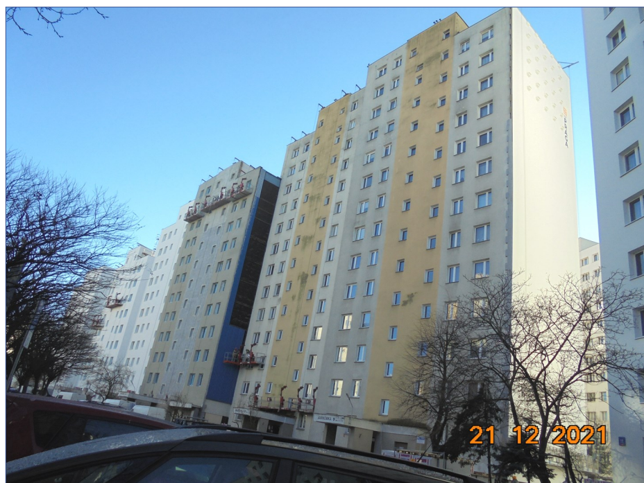
Janinówka 9 w trakcie remontu elewacji
