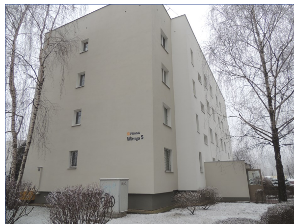
Wittiga 5 po renowacji elewacji
