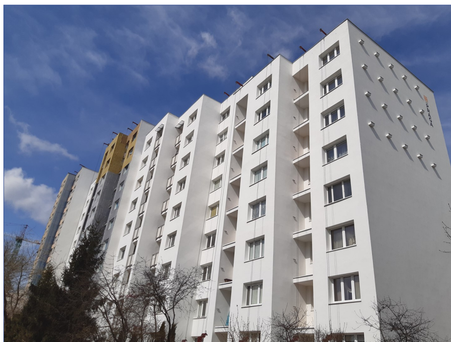
Janinówka 9 w trakcie remontu elewacji
