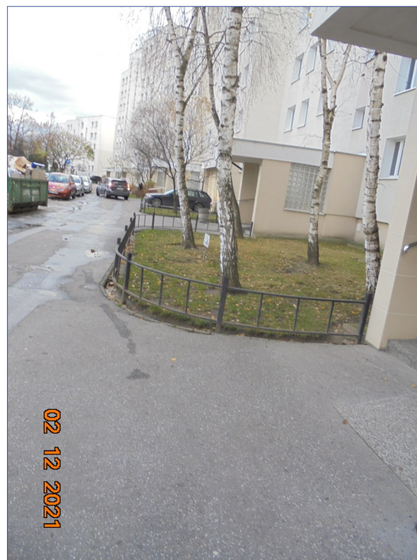
Gajkowicz 5 przed budową chodnika
