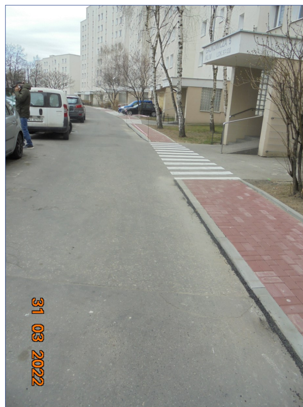
Nowy chodnik przed budynkiem Gajkowicza 5
