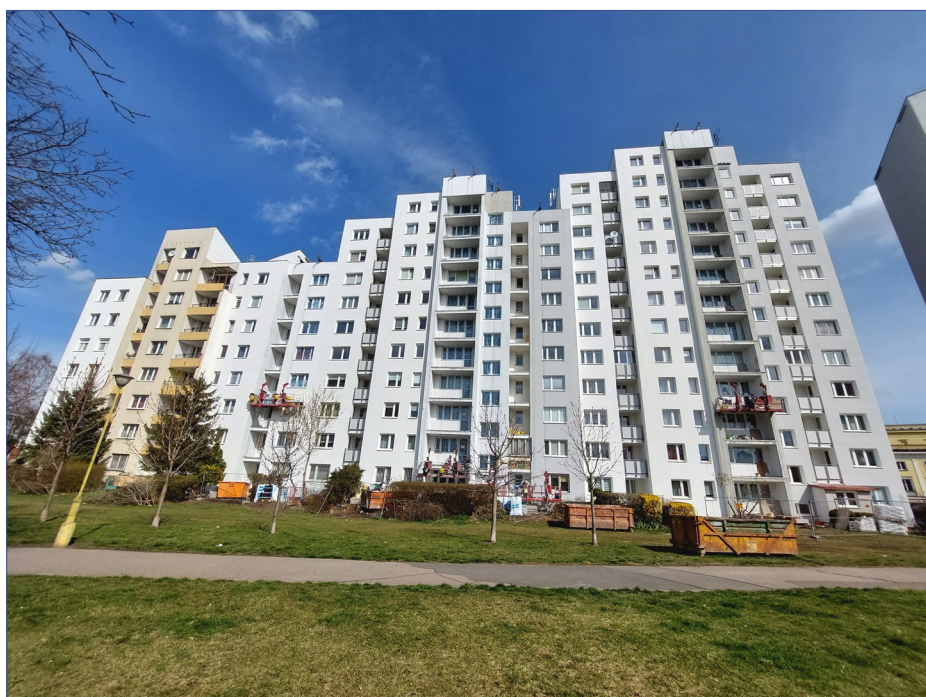
Kołowa 4 w trakcie renowacji elewacji
