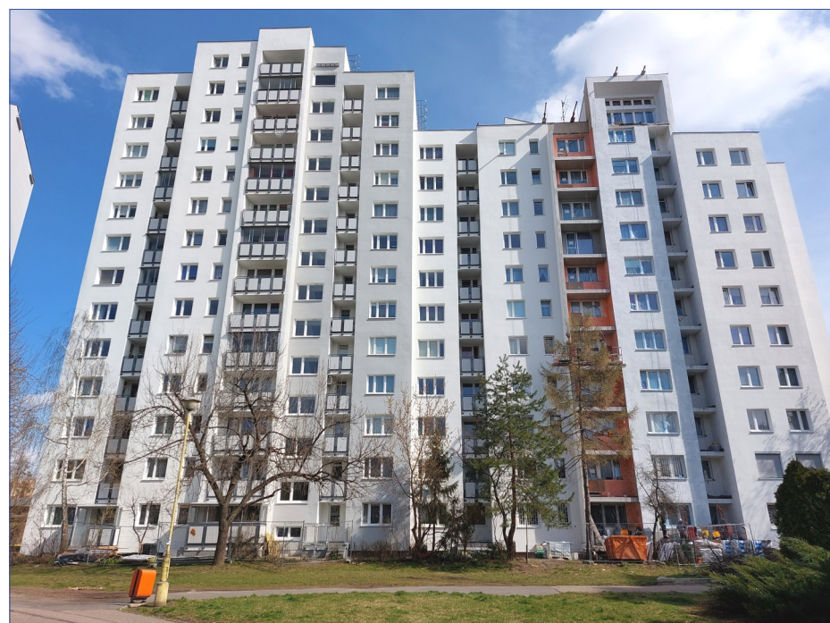
Kołowa 2 w trakcie renowacji elewacji
