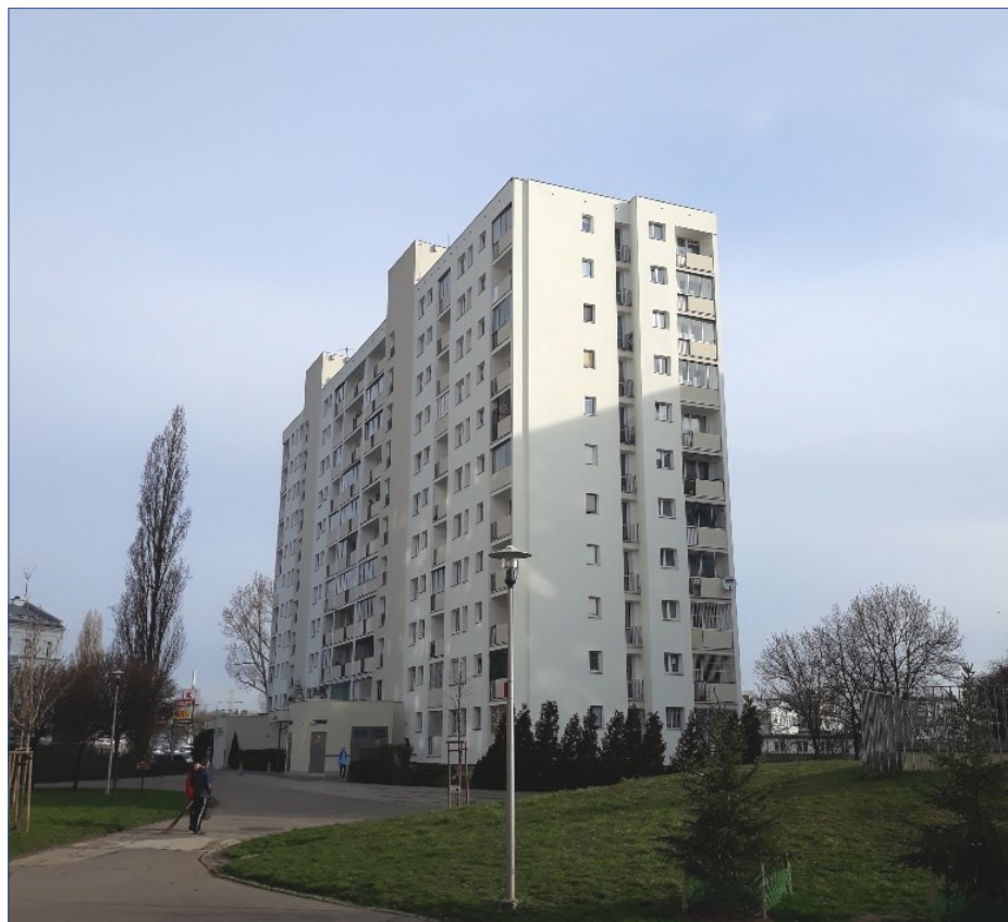
Radzywińska 68/72 po remoncie elewacji
