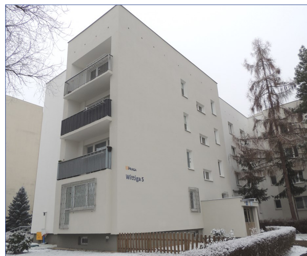
Wittiga 5 po renowacji elewacji
