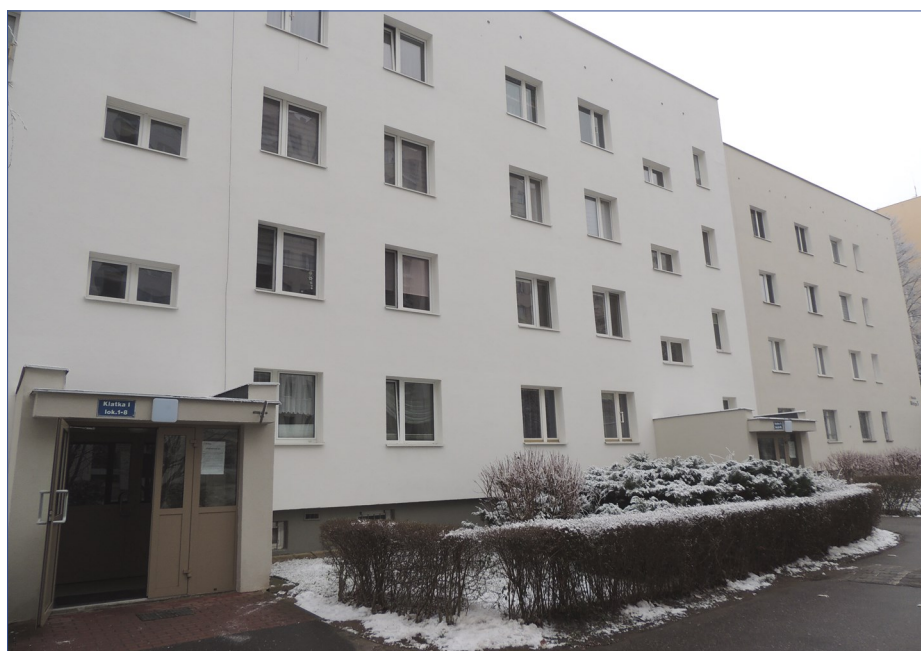
Wittiga 5 po renowacji elewacji
