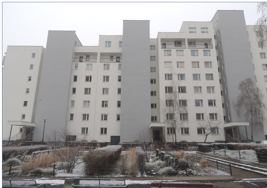
Śreniawitów 1 po renowacji elewacji
