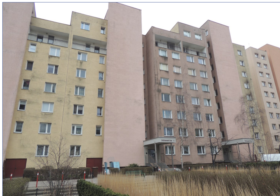
Śreniawitów 1 przed renowacją elewacji
