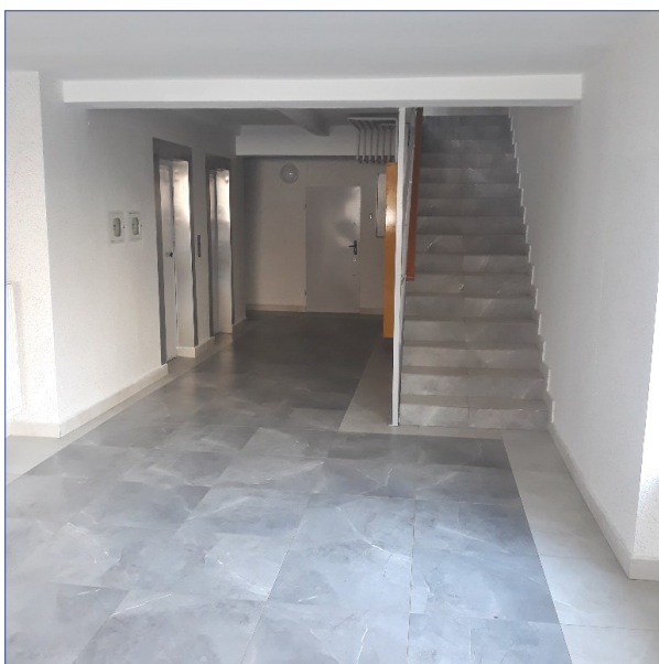
Markowska 6, klatka schodowa po remoncie
