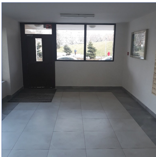
Markowska 6, klatka schodowa po remoncie
