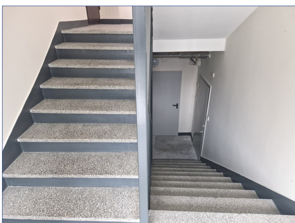
Kamińskiego 16, klatka schodowa po remoncie
