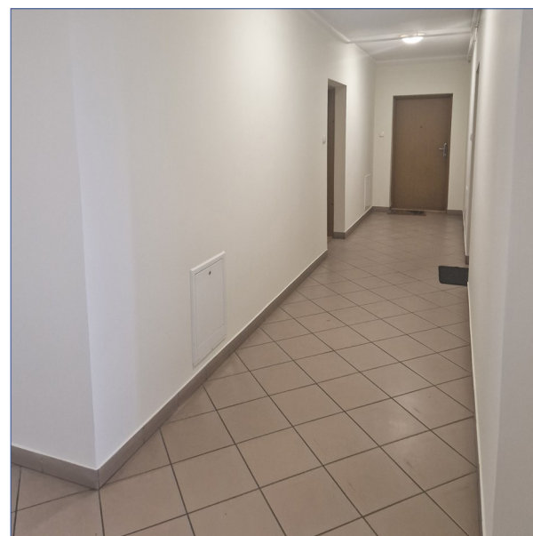
Ćmielowska 15A, klatka schodowa po remoncie
