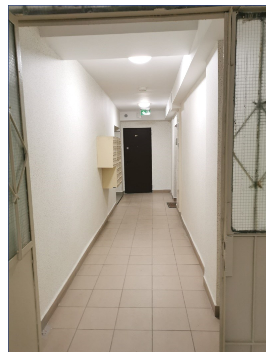
Łomżyńska 15/25, klatka schodowa po remoncie
