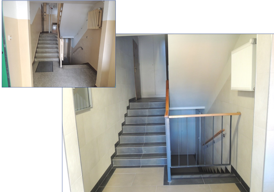
Budynek Pancera 13 przed i po remoncie klatek schodowych
