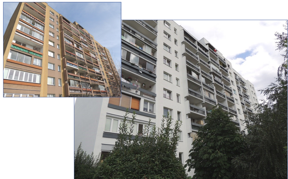
Budynek Nagodzców 2 przed i po remoncie elewacji
