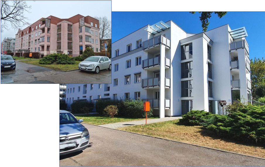
Budynek A. Kamińskiego 2 przed i po remoncie elewacji
