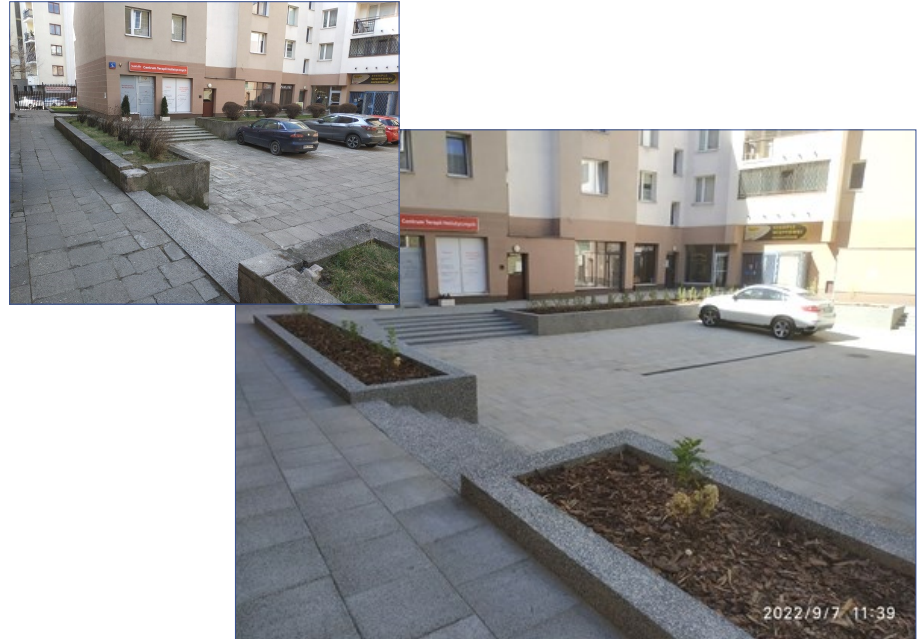
Patio Jagiellońska 1, 3, 5a przed i po remoncie
