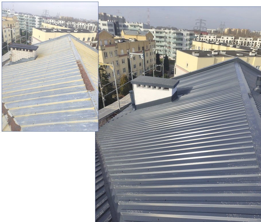
Budynek Kamińskiego przed i po remoncie dachu
