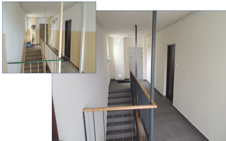
Budynek Atutowa 1 przed remontem i po remoncie klatek schodowych
