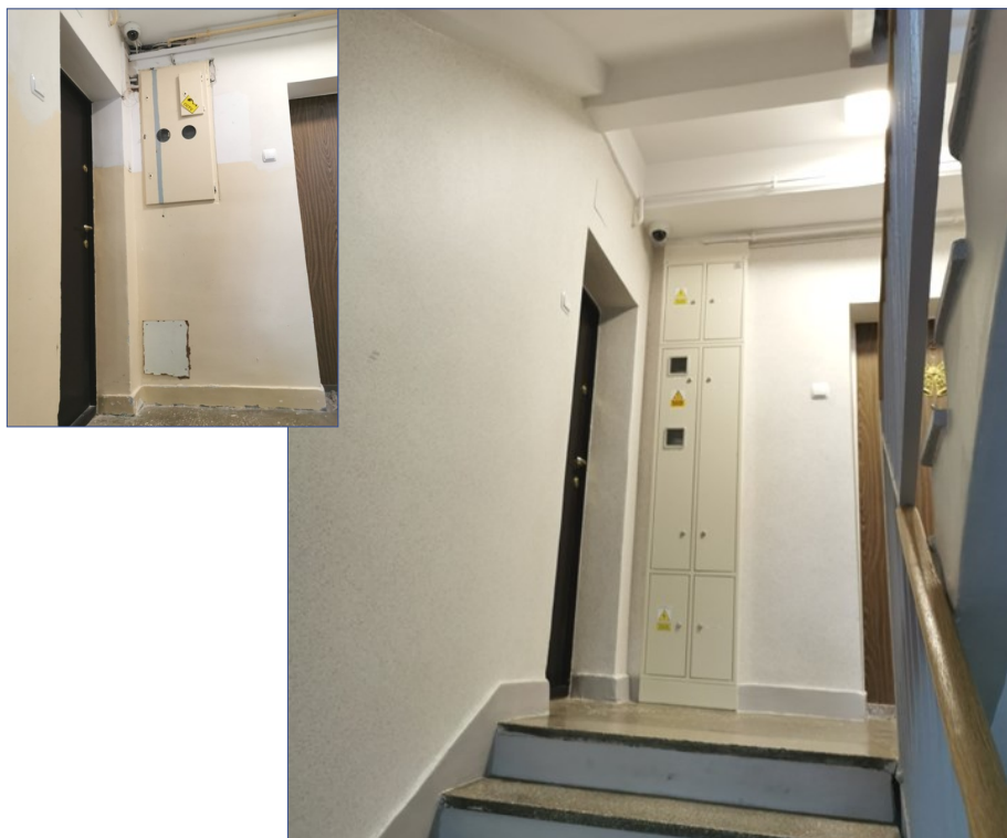
Łomżyńska 22/24 remont klatek schodowych
