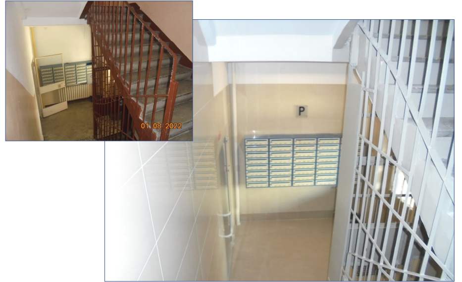
Zamiejska 17 po remoncie klatek schodowych
