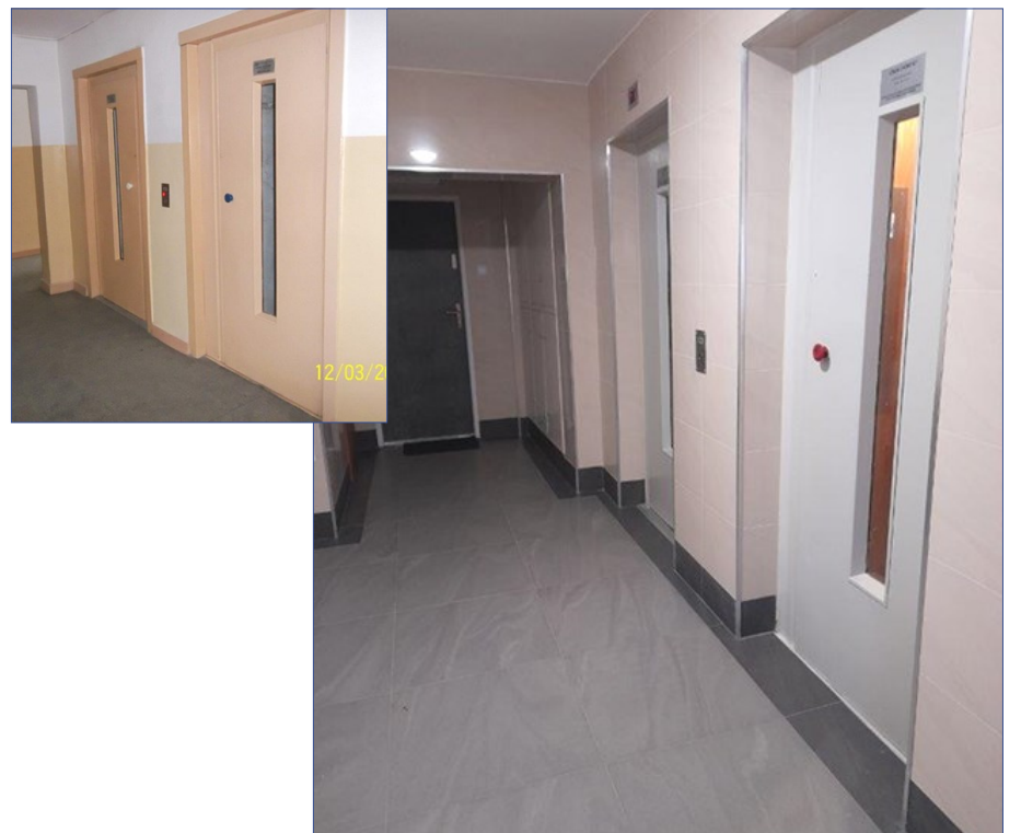
Junkiewicz 1 - klatka schodowa i windy przed i po remoncie
