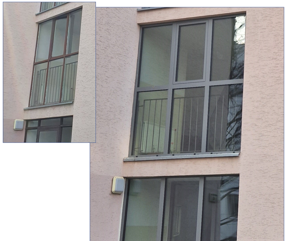
Przeszklenia na Kamińskiego 4A przed i po wymianie
