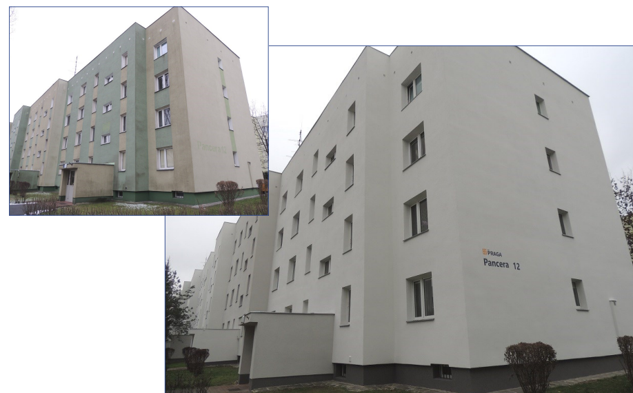
Budynek Pancera 12 przed i po remoncie elewacji
