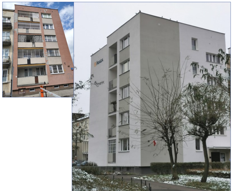
Wiosenna 1 renowacja, mycie i malowanie elewacji
