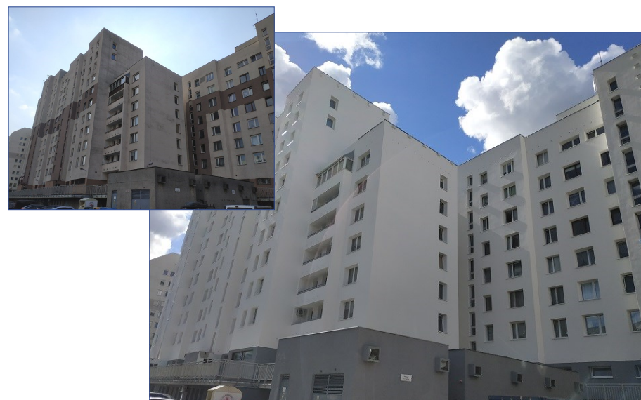
Budynek Jagiellońska 4 przed remontem i w trakcie remontu elewacji
