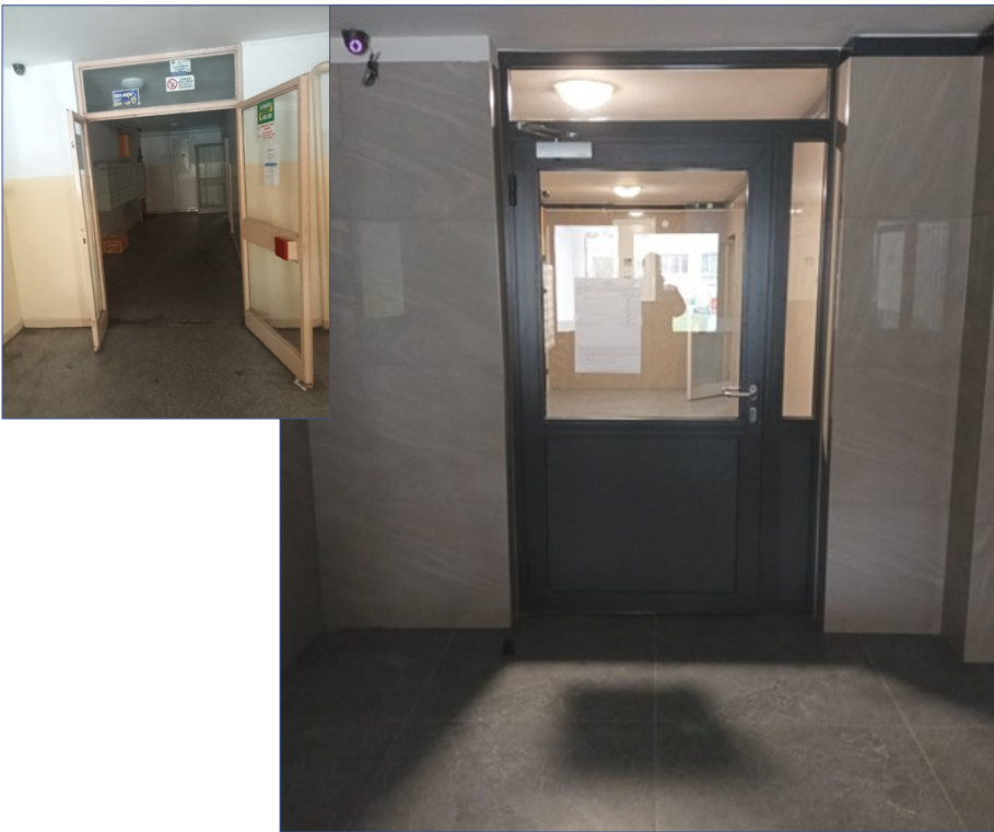
Budynek Wejherowska 3 przed i po remoncie klatki
