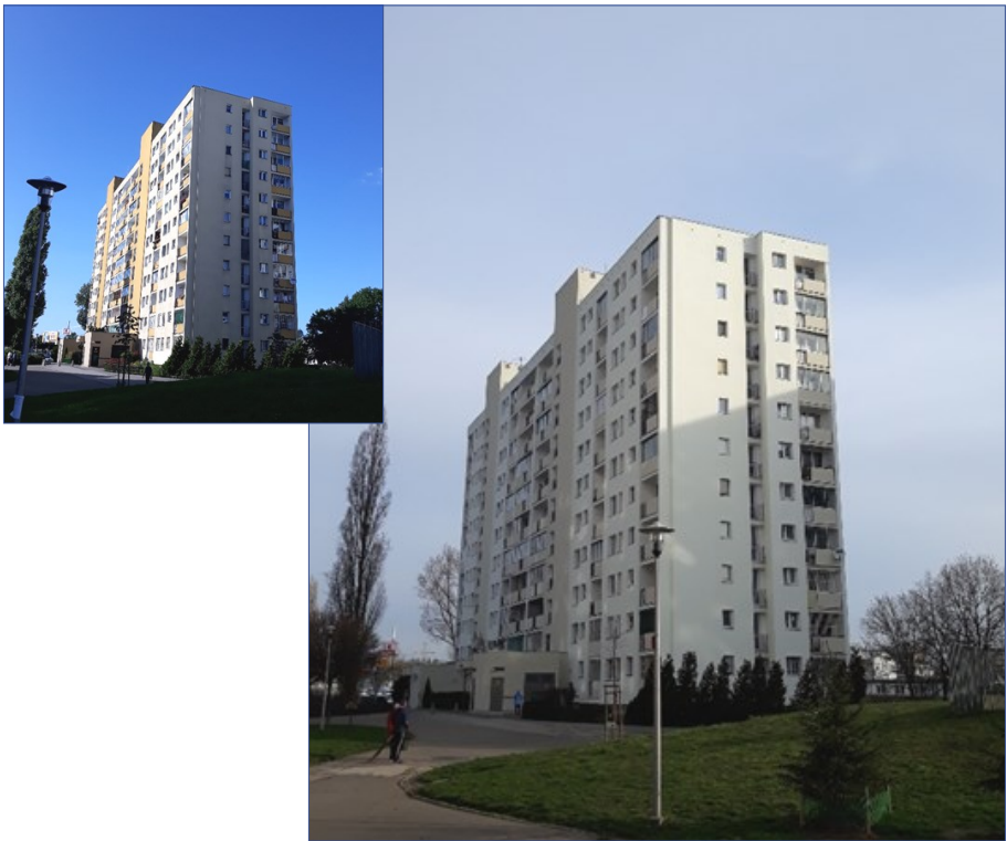
Budynek Radzyńska 68/72 przed i po remoncie elewacji
