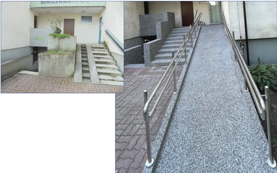
Nowy podjazd przy ul. Remiszewskiej 7
