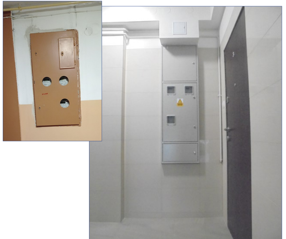
Janinówka 9 przed i po wymianie wewnętrznych linii zasilających
