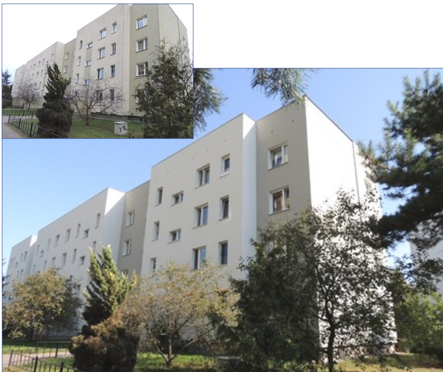
Budynek Pancera 14 przed i po remoncie elewacji
