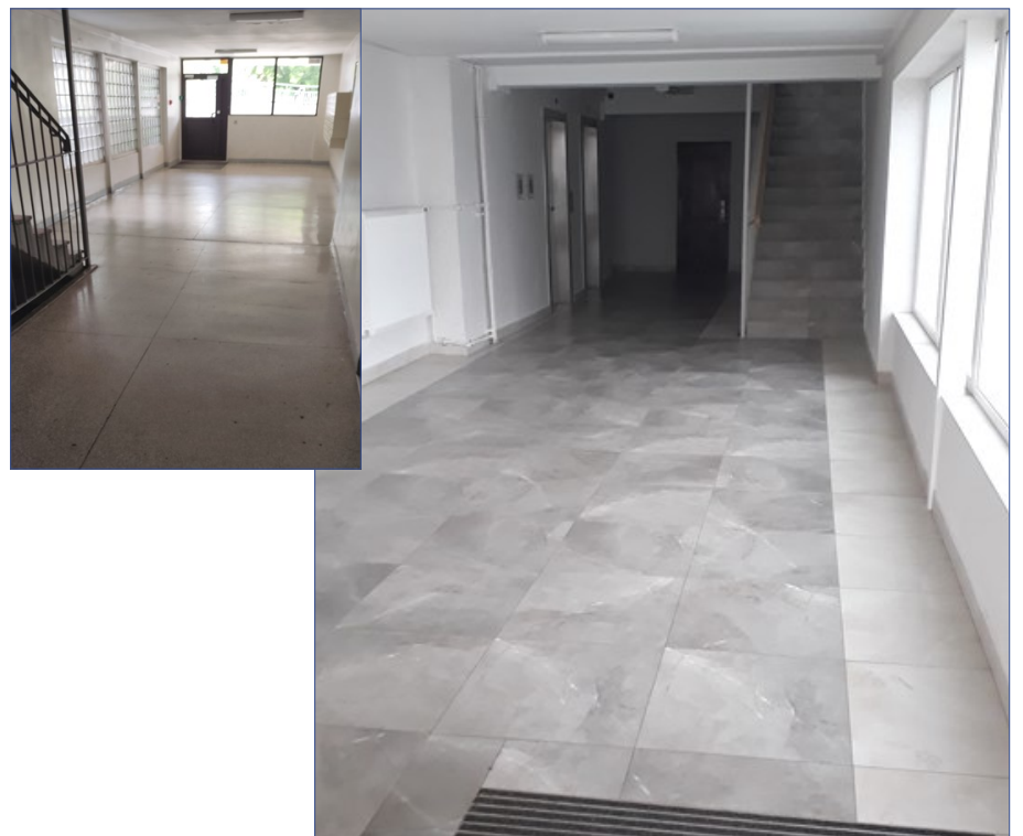
Budynek al. Tysiąclecia 151 klatki schodowe przed i po remoncie
