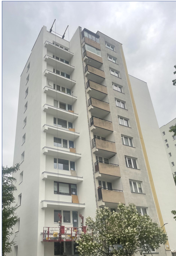
Kolejne etapy remontu.
