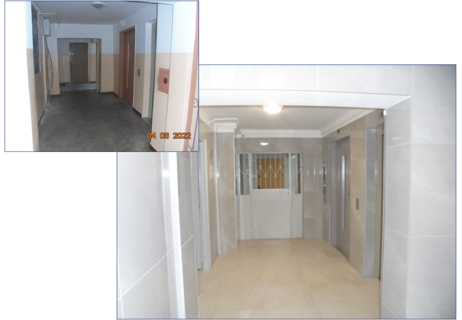
Budynek Askenazego 2 przed i po remoncie klatki
