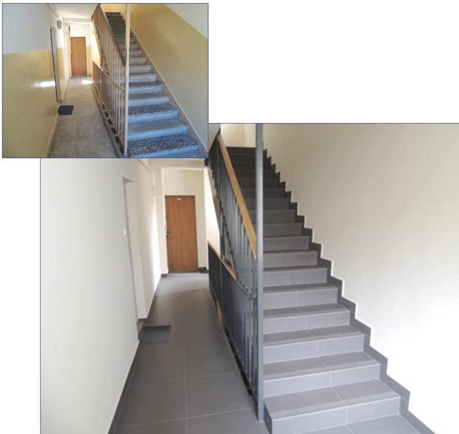
Budynek Szczęśliwa 2 przed i po remoncie klatek
