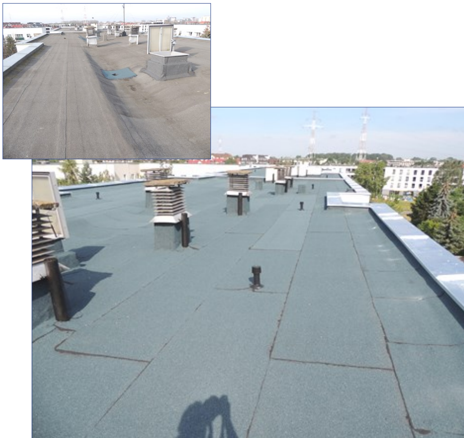
Dach Pancera 15 przed i po remoncie
